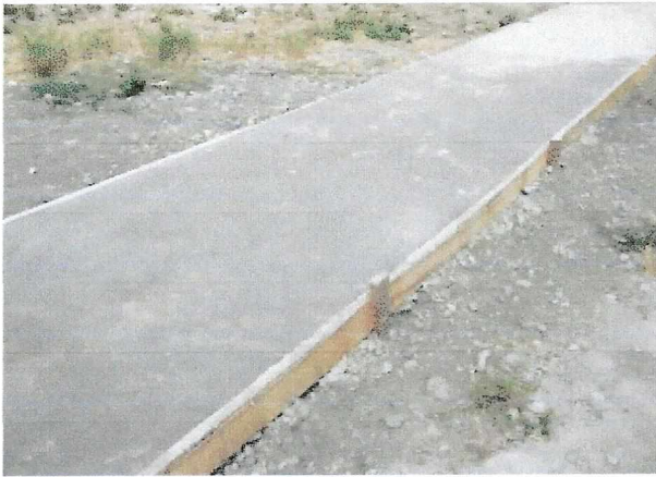
Fotografía N°27: Vista del radier con moldaje sin retirar.
