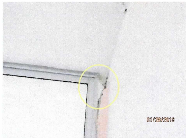
Fotografía N° 8: Detalle de la abertura entre la ventana y el muro.
