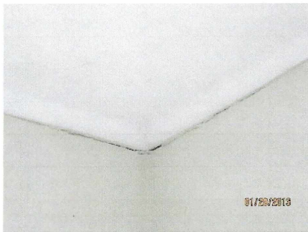
Fotografía N°21: Vista superior de muro con encuentro de cielo.
