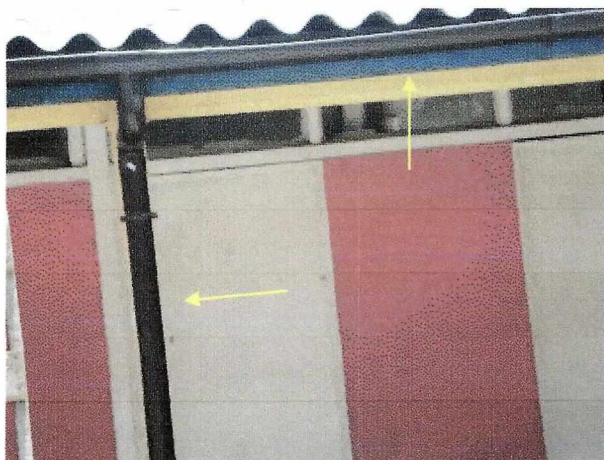
Fotografía N° 34: Canaleta y bajada de aguas lluvias de PVC.
