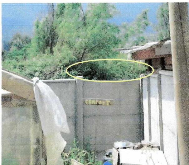
Fotografía N°5: Vista superior del cierre sin la barda sobre las placas.
