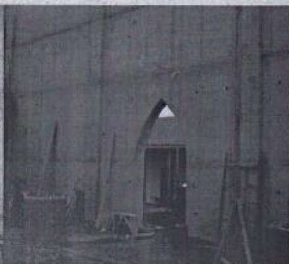
Fotografía N°6, de 3 de agosto de 2016: Vista interior de eje A, entre 4-5, graficado en la lámina A que contiene la elevación norte lateral esc. 1:100.
