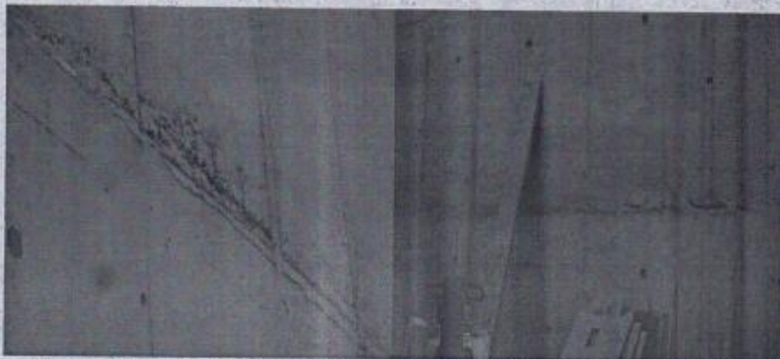
Fotografía N°18, de 3 de agosto de 2016: Enfierradura a la vista localizada en eje A, entre 5-5', de la lámina 3 que contiene la planta de estructura templo esc. 1:50.
