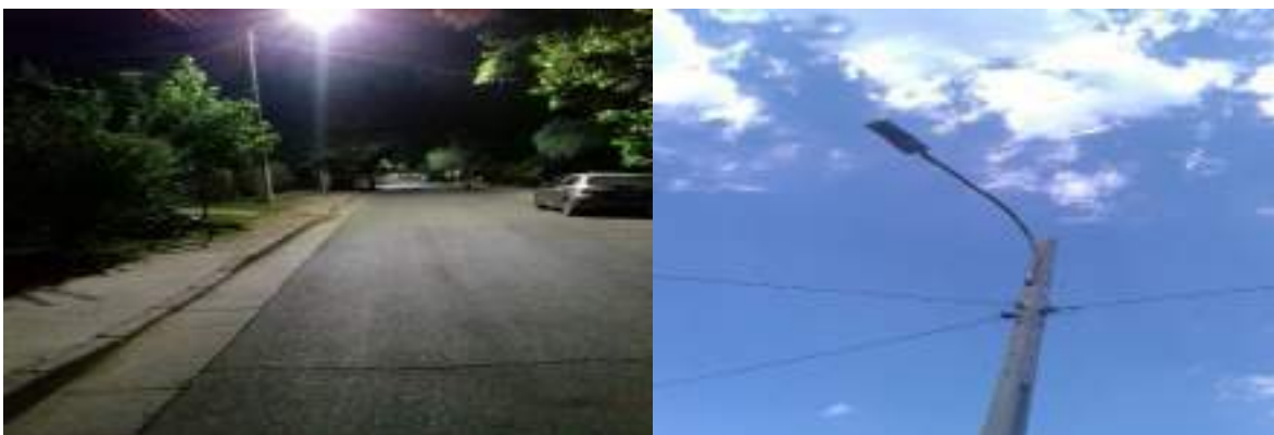
Proyecto FNSP Reparación Luminarias LED Doñihue
