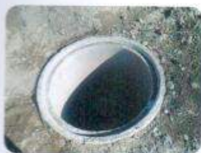
Obras de riego
