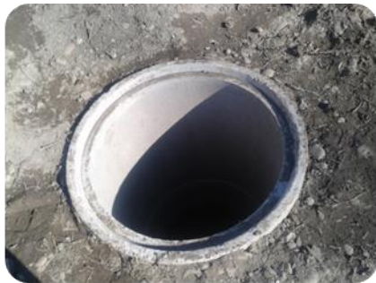
Obras de riego
