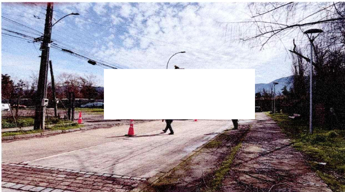
APOYO TRABAJOS REALIZADOS EN CAMARICO
